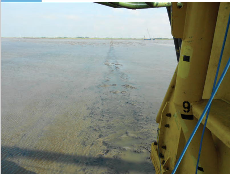
Abbildung 2: Verlegespalt im Watt (Foto: eos-projekt, Hannover)
